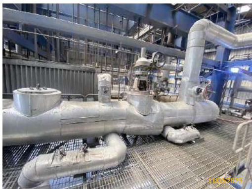
รูปที่ 2-39 การติดตั้งวาล์วควบคุม (Control Valve)
