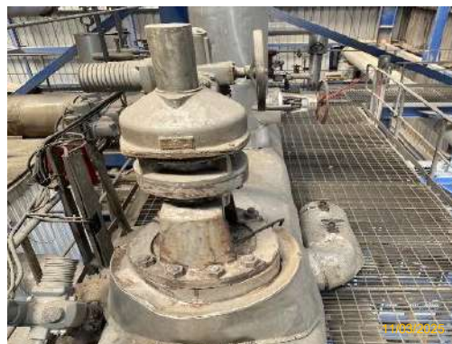
รูปที่ 2-40 การติดตั้งชุด Bypass Valve
